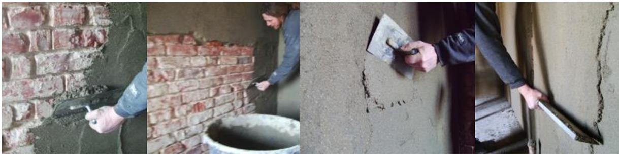
Mit der Glättkelle wird der HL-DU\_04 fest an die gereinigte Oberfläche aufgetragen. Ab 40 mm wird der HL-DU\_04 zweilagig aufgetragen.
