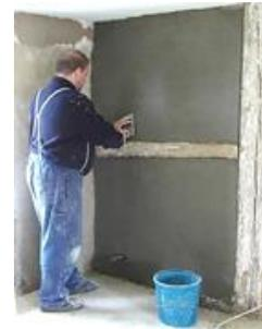
Alte Farb- und Putzreste vollständig entfernen! Ein Nässen dient auch der Säuberung. Auch Klinker- oder Ziegelwände vor dem Verputzen gründlich mit Wasser säubern. Ab 40 mm zweilagig auftragen.
